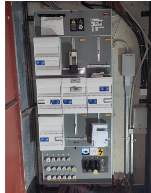
Haupttableau nach Einbau Smartme Zähler
