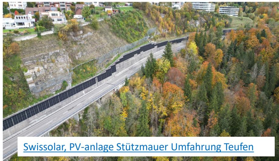
[Swissolar, PV-anlage Stützmauer Umfahrung Teufen](#)
